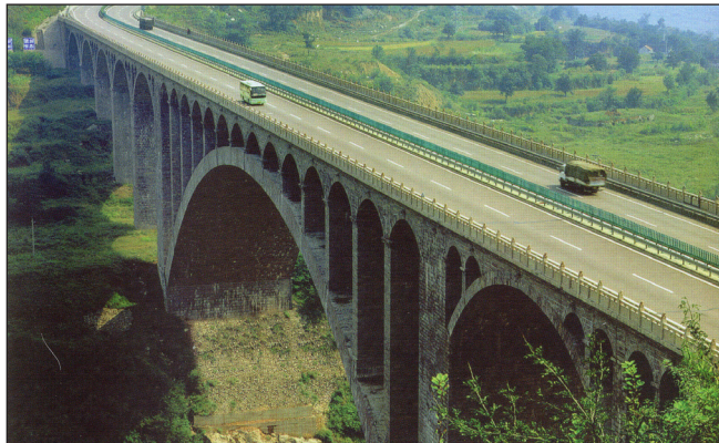
11d. ábra: Danhe híd felépítve
