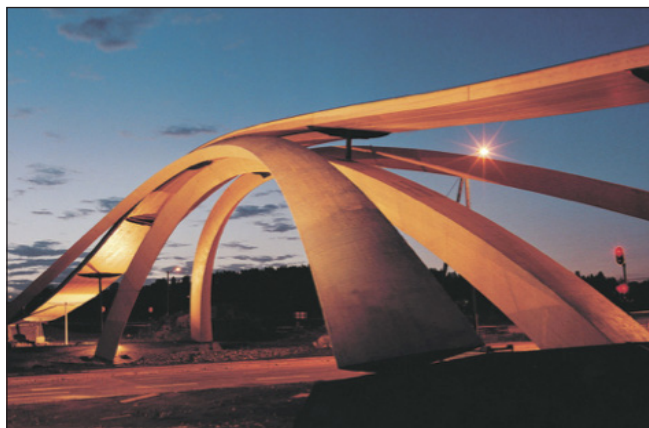
15. ábra: A „Da Vinci híd” fa lemezszelvényekből épült fel (Kép: Terje Johansen)
