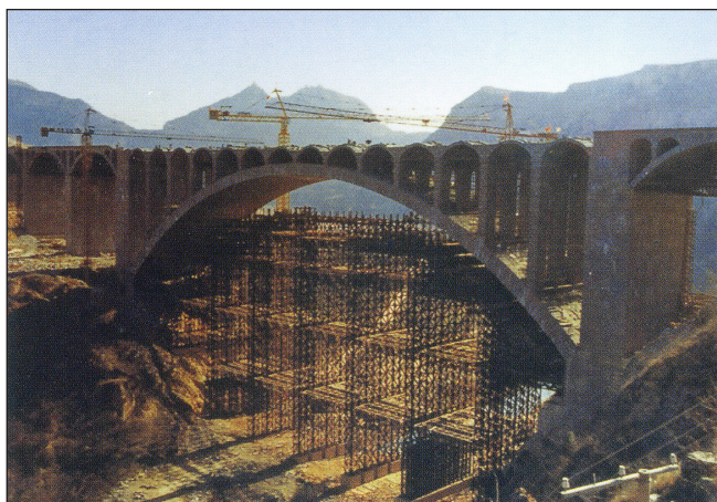
11c. ábra: A Danhe híd építése - acélvázszerkezet
